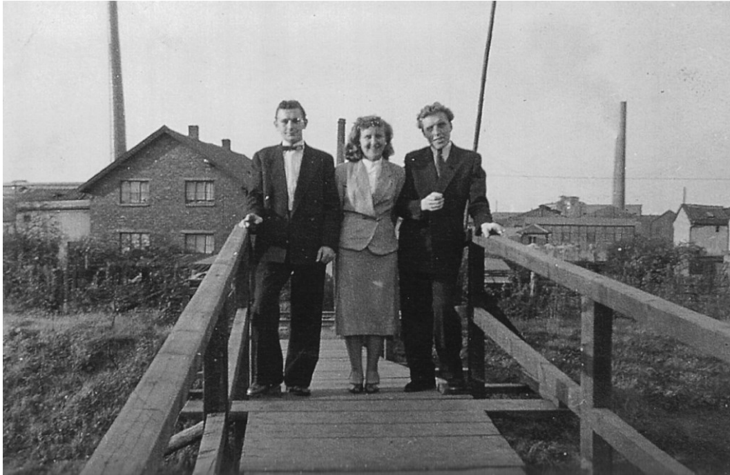
Eine Holzbrücke über den Sellmannsbach war die legendäre Lebensader für das Wohnhaus Werkstraße 1
