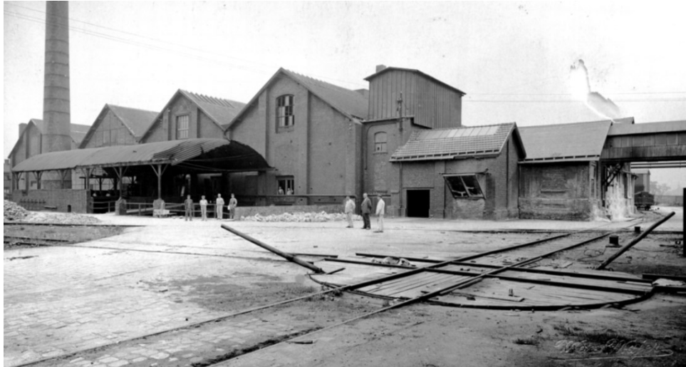
Diese undatierte Aufnahme des namhaften Gelsenkirchener Fotografen Max Majer zeigt noch etwas von den rauen Anfängen; im Vordergrund eine durch Muskelkraft betriebene Drehscheibe, im Hintergrund die um 1900 gebauten Sulfat-Lager.
