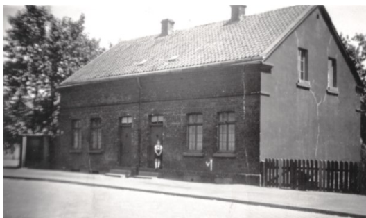
Das Arbeiterwohnhaus Wiesmannstraße 66 war ausnahmsweise ein Ziegelmassivbau
