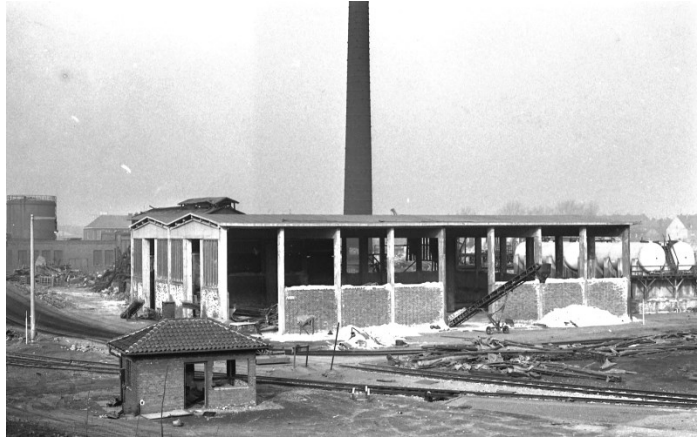
Blick Richtung Westen: links der Gasbehälter, der nahe an der Uechtingstraße stand, in der Mitte der Schornstein der Salzsäurefabrik von 1929; alle diese Aufnahmen des selbständigen Fotografen Kurt Müller vom Abbruch im Jahr 1972 gelangten als Nachlass an das ISG
