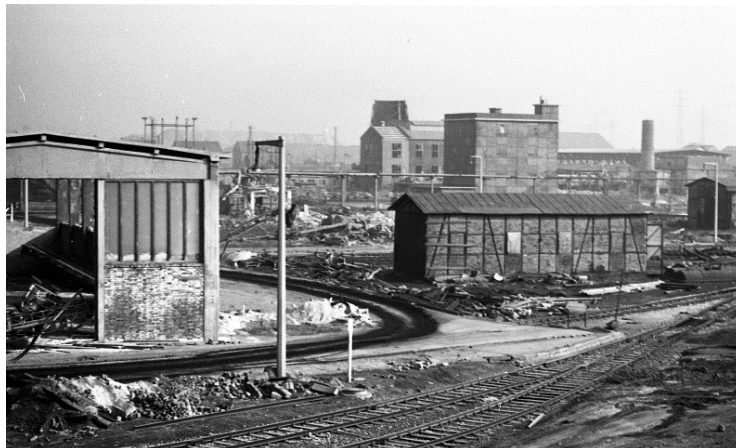
Blick in Richtung Nordost: der kubische Baukörper war 1906 für die Leichtöldestillation gebaut worden, dahinter Gebäude für die Schwefelstoffgewinnung, über die Halle links ragt das Gestänge eines 1966 errichteten Gasometers, eines der jüngsten Bauteile des Werkes.
