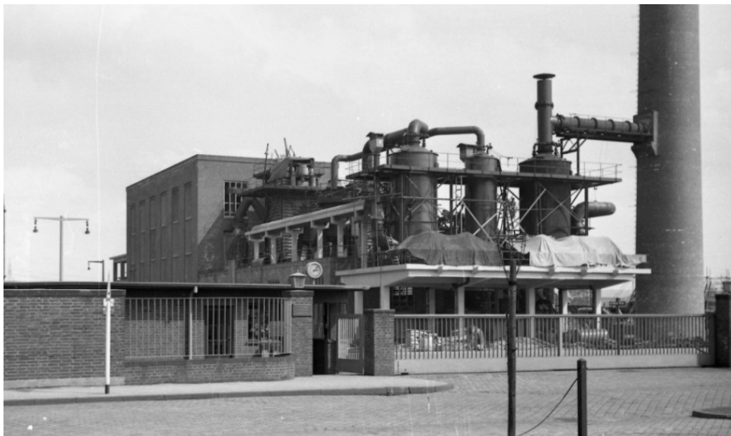
Die Aufnahme des Berufsfotografen Müller aus dem Jahr 1957 zeigt neue Teile der Schwefelsäurefabrik, der aufgeständerte Teil wurde in den Bauakten als Absorptionsbühne bezeichnet.
