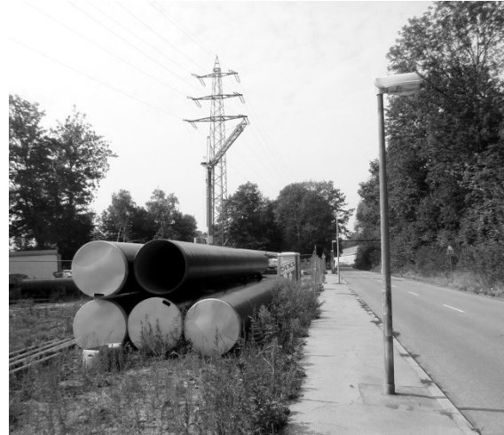
Rohre liegen bereit, in Zukunft das Schmutzwasser aufzunehmen, oben wird dann nur noch sauberes Wasser fließen
