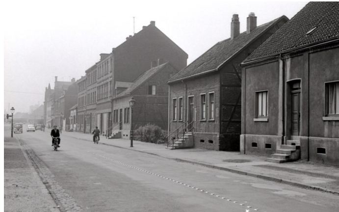
Uechtingstraße, Blick nach Süden
