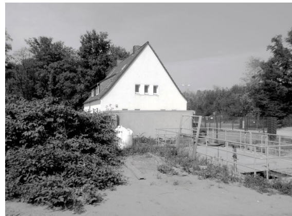
Das Gebäude wurde in den 1930er Jahren für die Bediensteten des Pumpwerkes der Emschergenossenschaft gebaut
