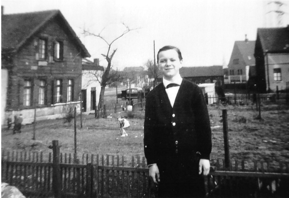
Die Aufnahme verdeutlicht recht gut, wie die ehemalige Bebauung im Bereich des Wohnhauses Wiesmannstraße 46 (links) aussah. Auf der rechten Seite befindet sich das Wohnhaus Werkstraße 2 und dahinter das Pumpwerk Wiesmannstraße 42-44 (jetzt noch vorhanden).
